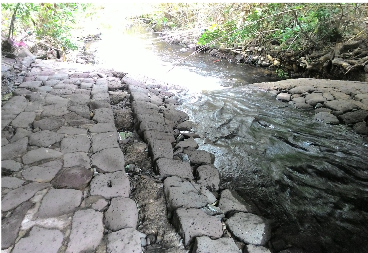
Foto n. 4 – Riu Mannu, particolare della soglia di fondo verso valle dell'attraversamento della S.P. n. 17
