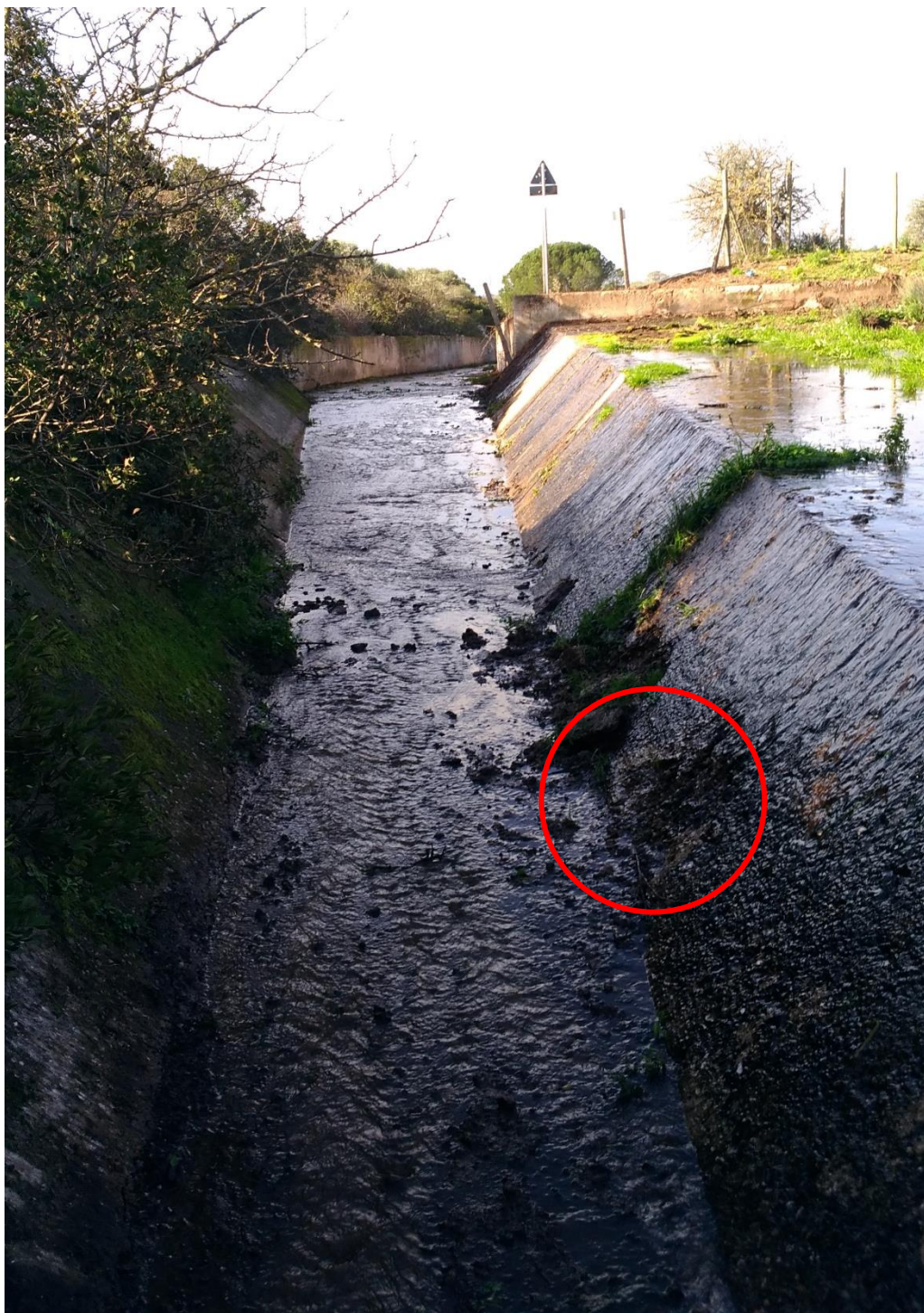
Figura 10 - Sfioratore superficiale e imbocco del canale fugatore
