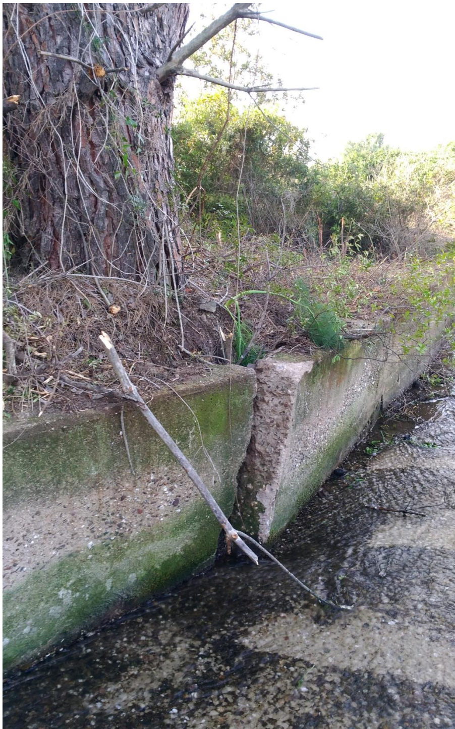
Figura 12 - Frattura della sponda sinistra a causa dell'albero
